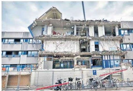
De sloop van het voormalige EKP is volop gaande. FOTO UNITED PHOTOS/PAUL VREEKER
